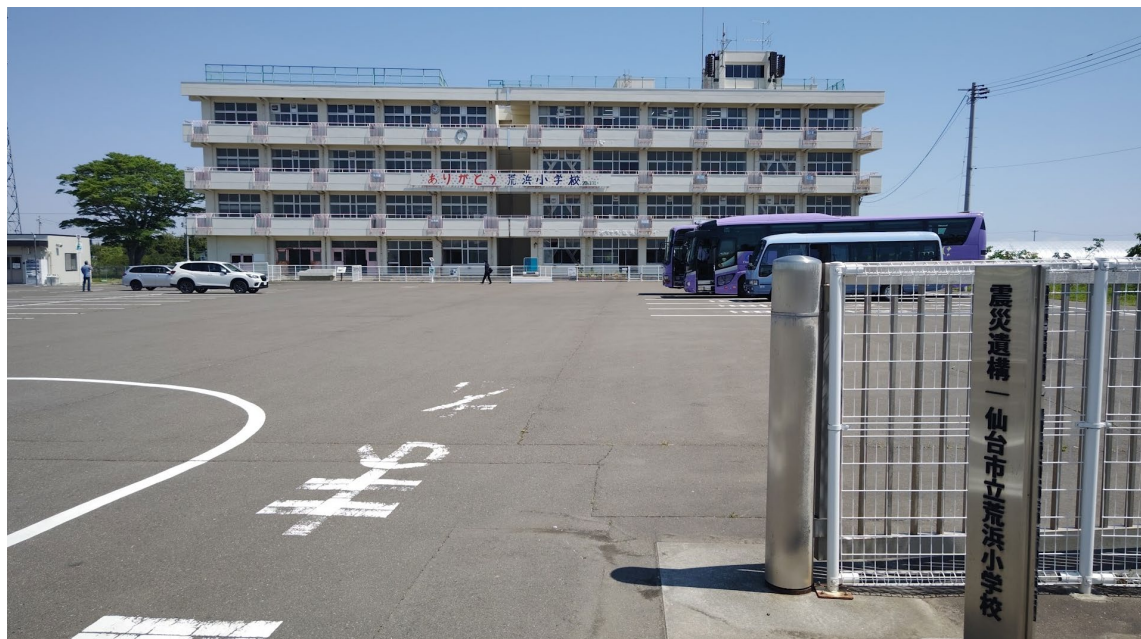
震災遺構 仙台市立荒浜小学校
