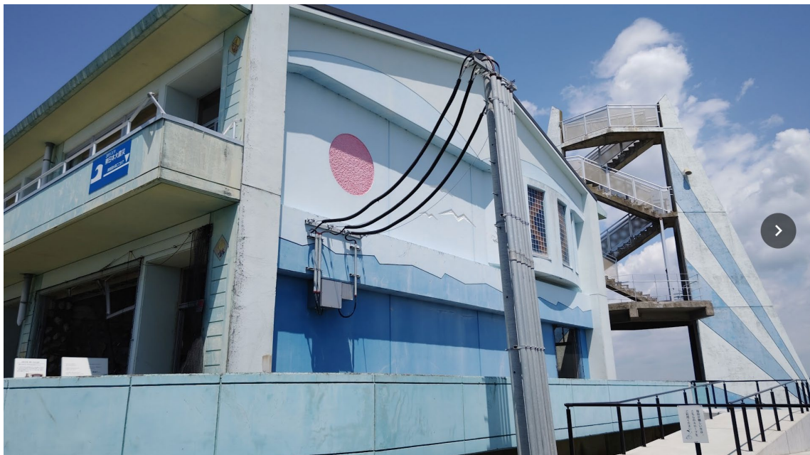
震災遺構 浪江町立請戸小学校（2 階ベランダに津波到達地点を表す標示板がある）
